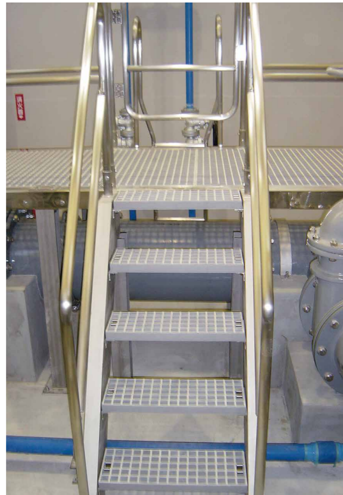
階段踏板施工例
